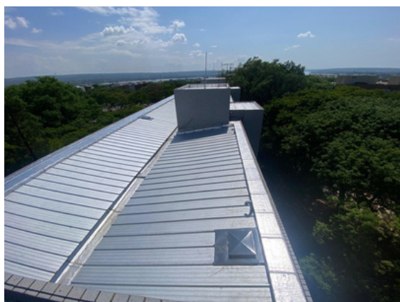
Condomínio do Bloco E da SQN 105 Asa Norte – Brasília – DF
