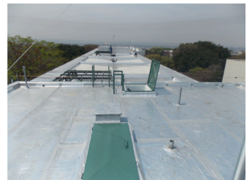
Impermeabilização com manta asfáltica no telhado do Condomínio do Bloco B da SQS 308, Asa Sul Brasília – DF
