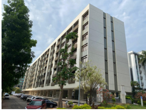
Condomínio do Bloco D da SQN 202 Asa Norte – Brasília-DF
