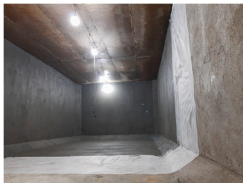
Impermeabilização de reservatório do Condomínio Tia Vitória, Gama, Brasília-DF
